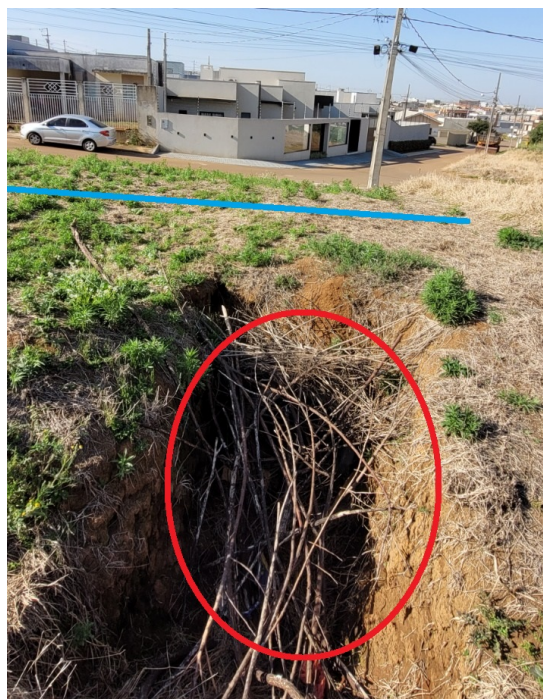
Figura 3.7: Escavação no lote com evidência de infraestrutura enterrada (tubulação). A linha azul representa a localização da ERT e o círculo vermelho a posição da tubulação. Fonte: acervo de campo.
