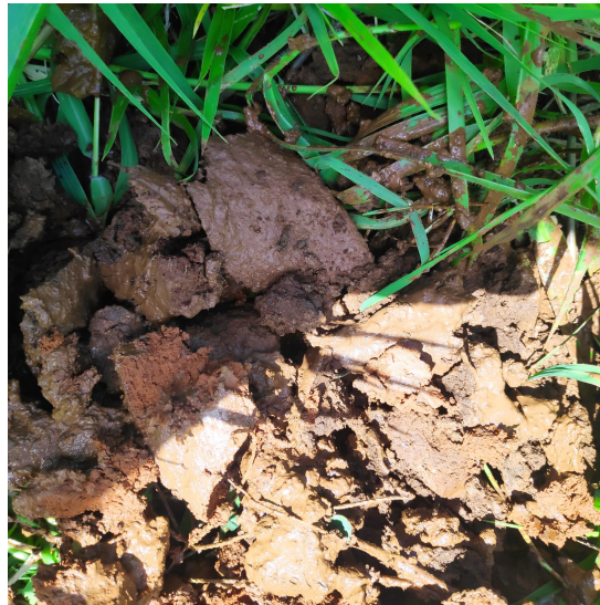
Figura 3.2: Solo siltoso obtido nos furos de trado. Fonte: acervo de campo.
